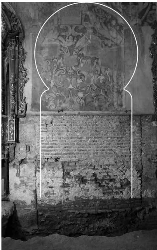
FIG. 14. Arco por la parte interior del muro.
