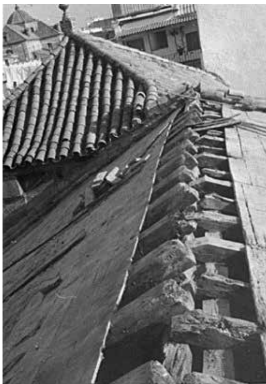
FIG 19. Vista de la cubierta del crucero antes del remonte de 1970.
