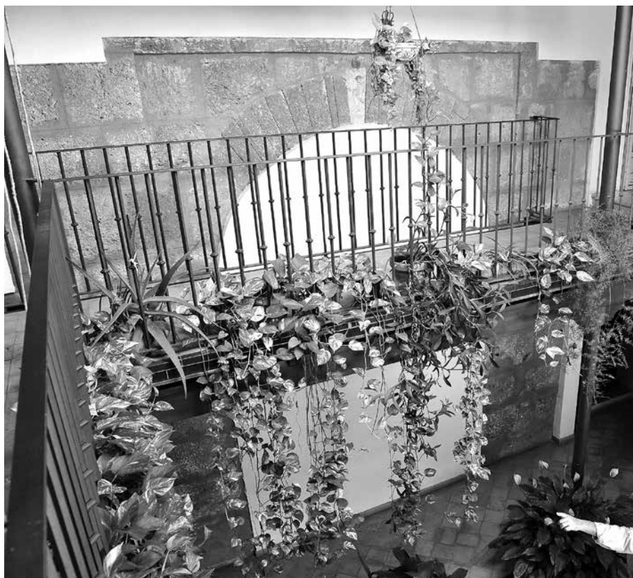
FIG. 3. Puerta de acceso desde el patio.
