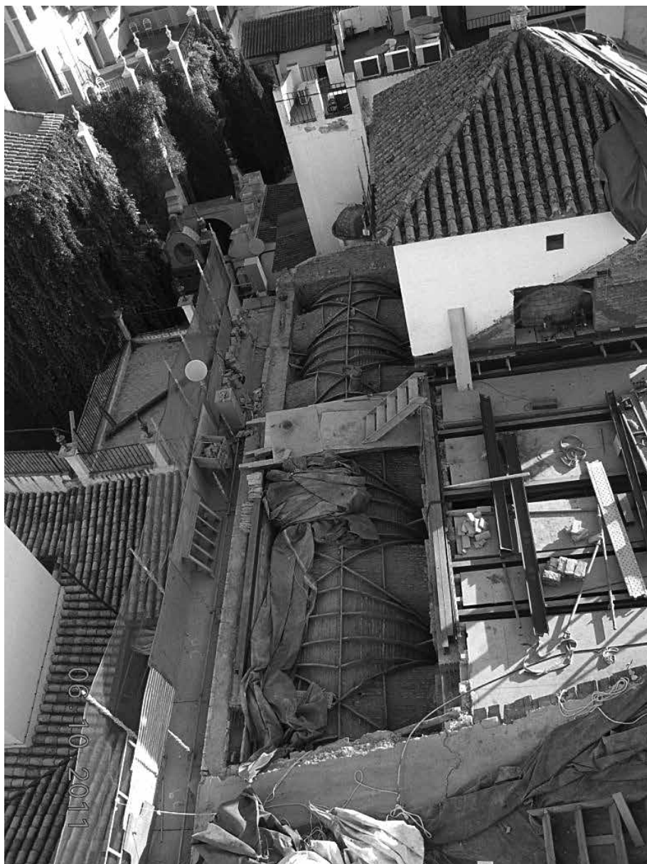
FIG. 20. Vista de la cubierta desmontada. Se aprecia el trasdós de las bóvedas de la nave del evangelio.
