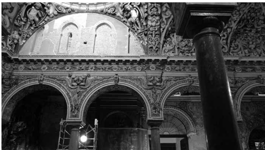
FIG. 17. Tímpano del falso crucero con las ventanas descubiertas.
